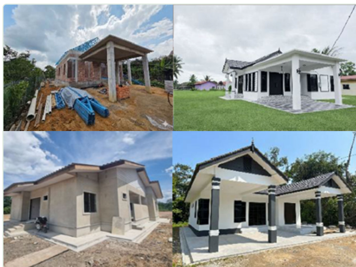
Projek pembinaan 4 unit rumah banglo di atas tanah sendiri — Koperasi sebagai kontraktor utama
