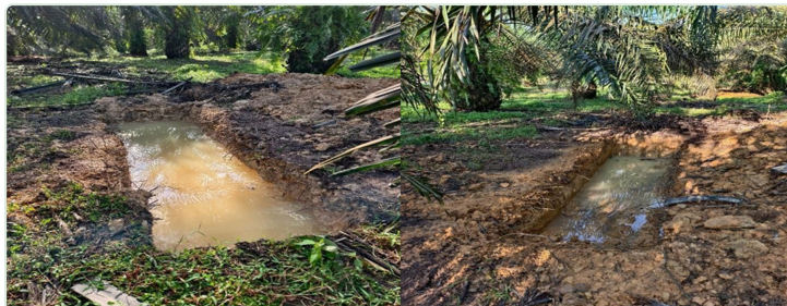
Pembinaan dan penyelenggaraan 188 unit silt pit di kawasan strategik ladang KWPTB hasil daripada lawatan penanda aras ke Koperasi Ladang Berhad
