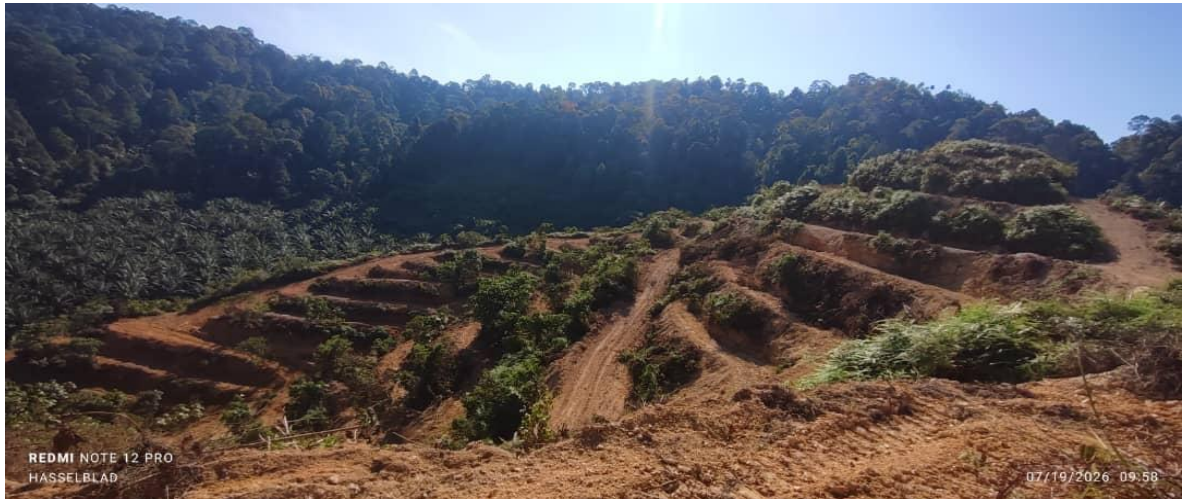
BUKIT 2D YANG KE-2 SIAP MEMBUAT TERES DAN JALAN
