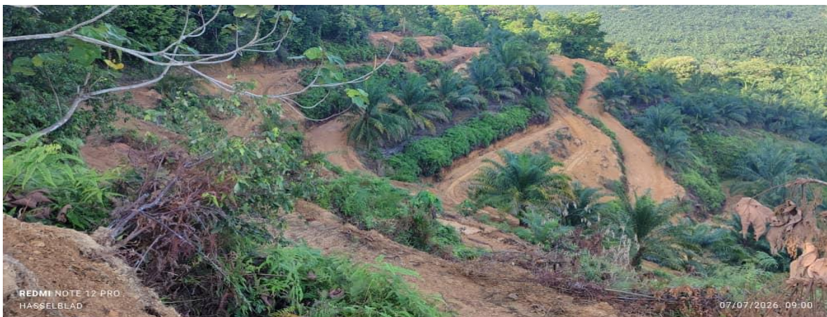
HASIL KERJA-KERJA MEMBUAT TERES DAN JALAN DI BLOK 2G
