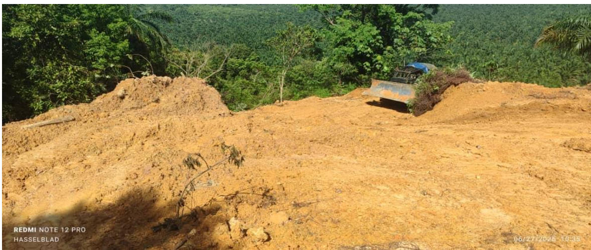
KERJA-KERJA MEMBUAT TERES DAN JALAN DIBUAT OLEH BULLDOZER BLOK 2G
