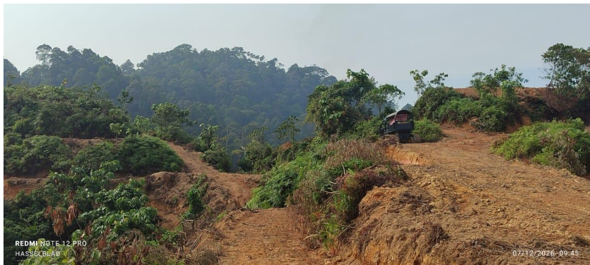
BULLDOZER SEDANG MEMBERSIH JALAN DAN TERES BLOK 2D ATAS BUKIT
